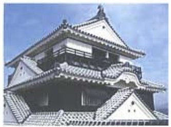
松山城天守閣 大天守は三重三階地下二階の層塔型天守で、黒船来航の翌年落成した江戸時代最後の完全な城郭建築です。また、「現存12天守」の中で、唯一、築城主として瓦には葵の御紋が付されています。
